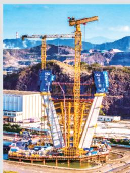
1月15日,浙江交通集团甬江特大桥首个主塔下横梁浇筑完成,标志这座世界最大跨径的三塔不对称斜拉桥开始进入中塔塔柱施工阶段。
