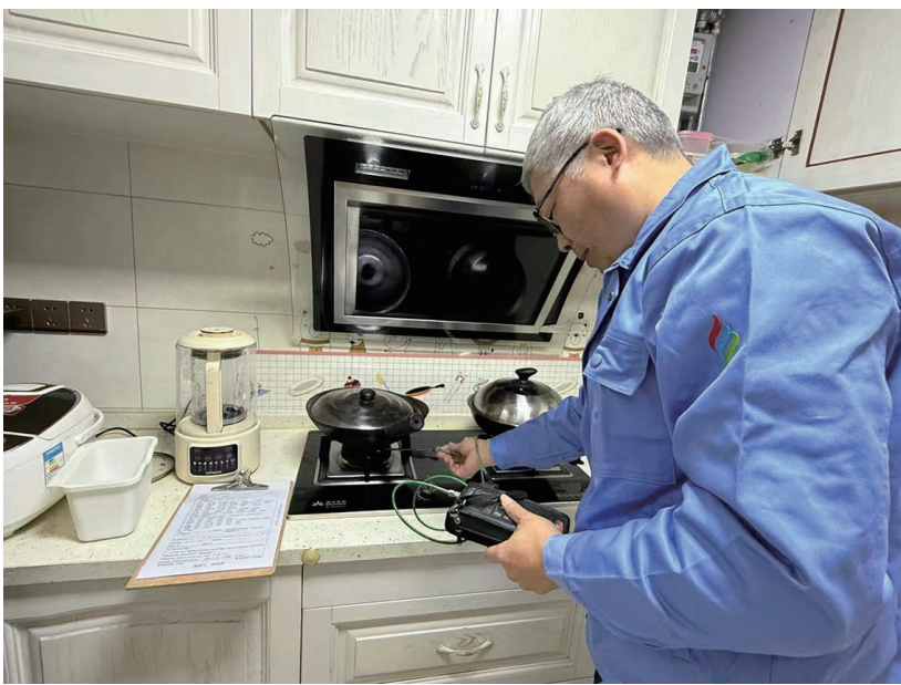
叶渊在居民家中检测燃气。 记者沈佳慧 摄
