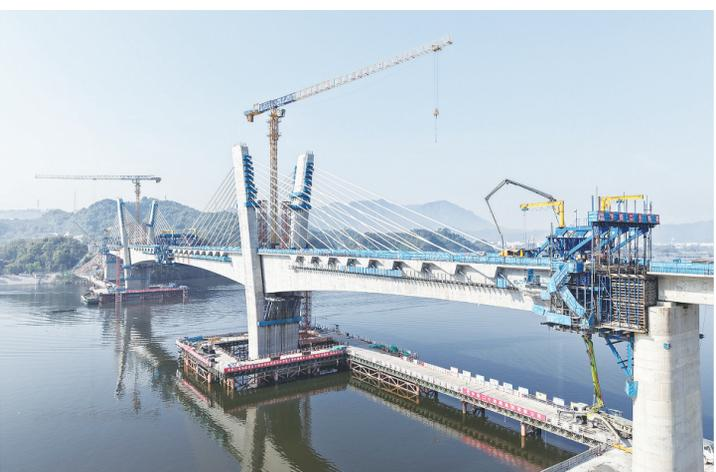
近日，由中铁二十四局承建的金建高铁新安江特大桥36根斜拉索全部安装完成，标志着金建高铁控制性工程新安江特大桥进入最后冲刺阶段，为后续大桥合龙及全线贯通奠定了坚实的基础。
