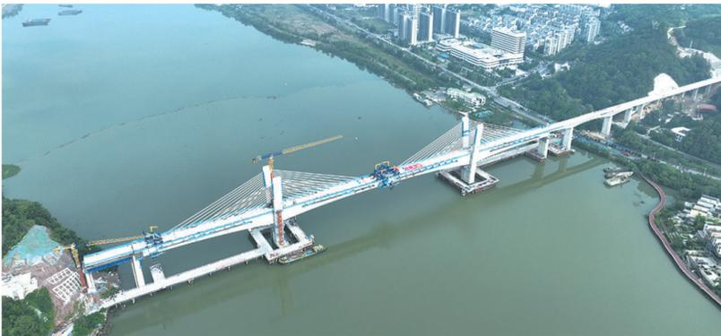
金建高铁由浙江交通集团主导投资建设。新安江特大桥梁位于建德市境内,该桥全长885.2米,主跨为216米的双塔双索面矮塔斜拉桥,其中Y型索塔结构形式高桥跨在华东地区属于首例,外倾式斜塔与斜拉索共同构成大跨度造型,与美丽的自然风光融为一体,由中铁二十四局承建。
